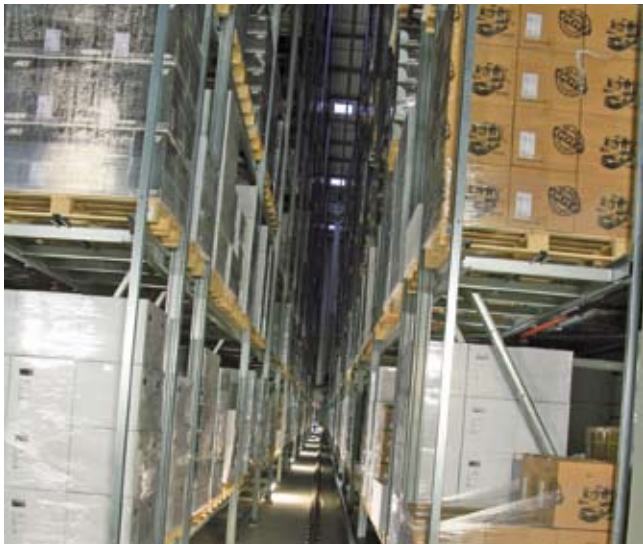
49 Meter breit, 100 Meter lang, 24 Meter hoch und rund 15 Mio. Euro teuer: das neue Hochregallager von ALCAR.
